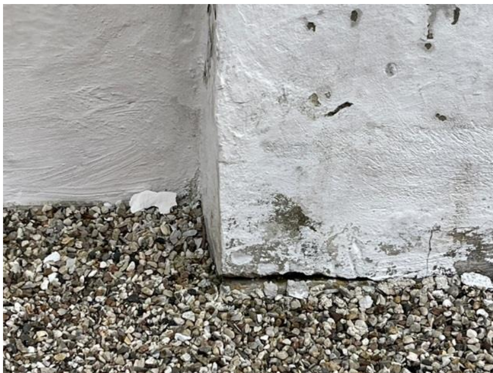
Mur slået fra fundament
