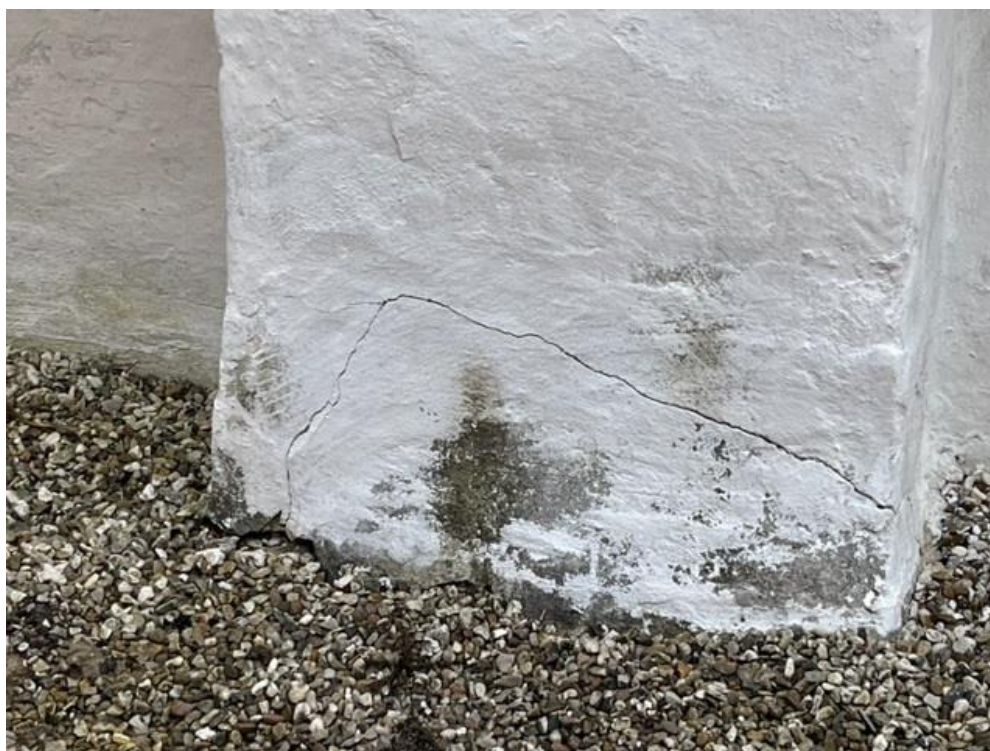
Revnet mur ved fundament
